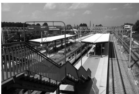
Rys. 13. Obiekty zbudowane na linii kolejowej
