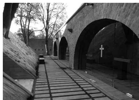
Rys. 15. Obiekt Cytadeli Warszawskiej
