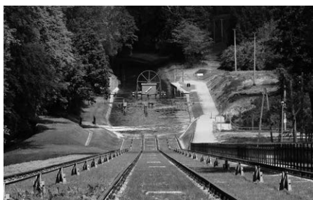
Rys. 17. Fragment Kanału Elbląskiego po rewitalizacji
