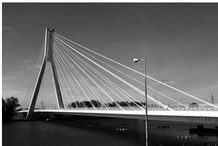
Rys. 20. Most podwieszony im. Tadeusza Mazowieckiego przez rzekę Wisłok w Rzeszowie
