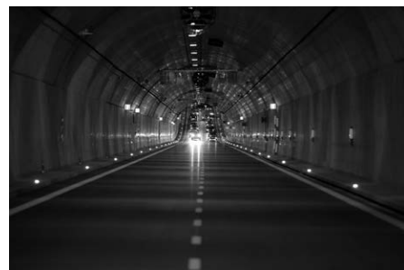
Rys. 19. Tunel drogowy pod Martwą Wisłą w Gdańsku
