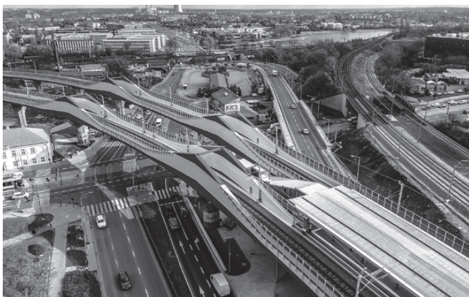
Rys. 12. Budowa łącznicy kolejowej Kraków Zabłocie – Kraków Podgórze
