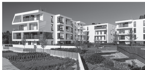
Rys. 2. Zespół budynków mieszkalnych wielorodzinnych z garażami podziemnymi OKRZEI w Sopocie
