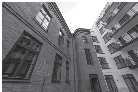
Rys. 5. FABRYKA NA PRADZE – budynek B w Warszawie
