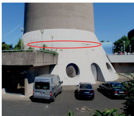
Rys. 3. Podstawa z głębokimi odpryskami
