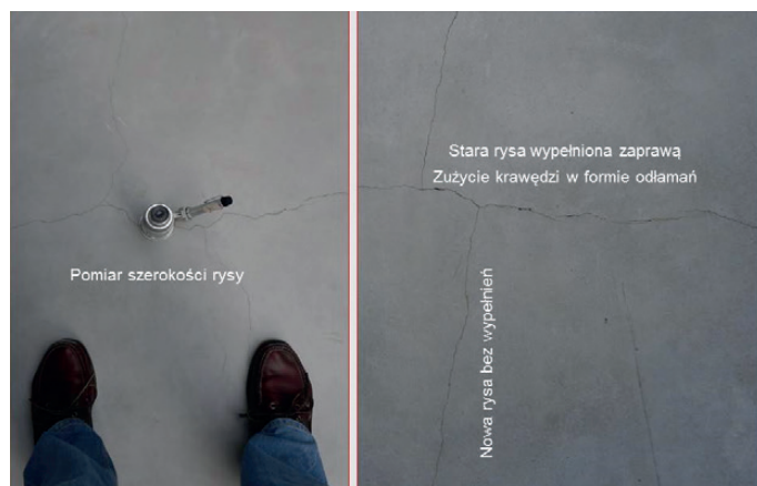
Rys. 6. Wygląd rys
