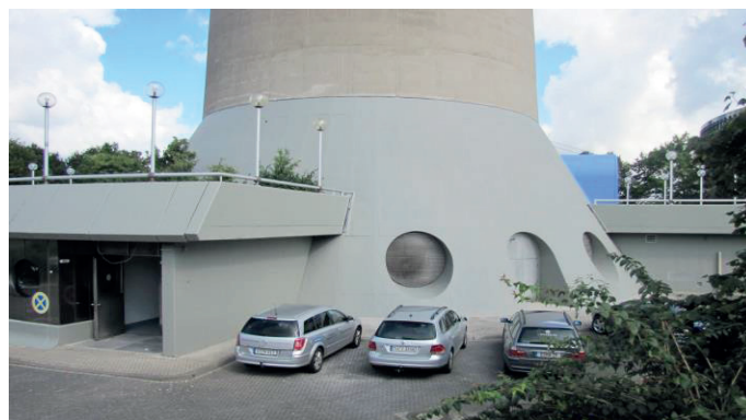
Rys. 8. Podstawa wieży po naprawie
