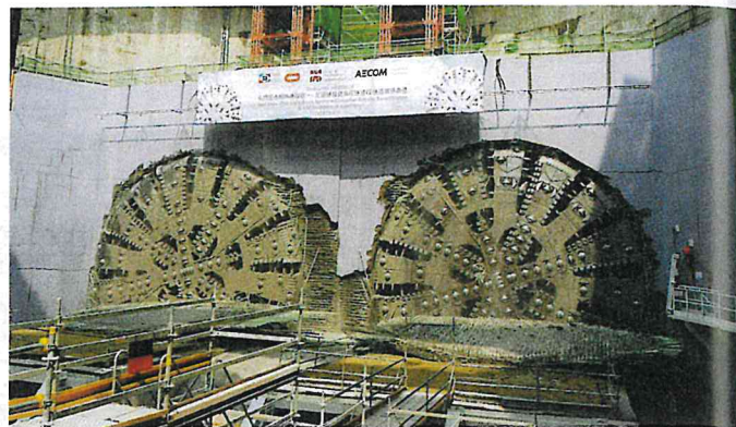
Rys. 5. Dwie tarcze zawieszinowe o średnicy 14 m jednocześnie wchodzą do komory odbiorczej po wydrążeniu 2 x 5 km tunelu Tuen Mun-Chek Lap Kok [5]
