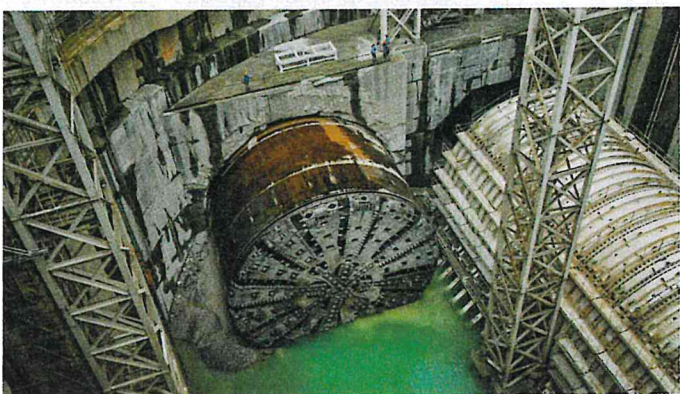
Rys. 4. Tarcza zawieszinowa o średnicy 17,63 m w momencie wejścia do pośredniej komory odbiorczej; z prawej widoczne przejście przez komorę maszyny o średnicy 14 m drążącej równoległy tunel [5]
