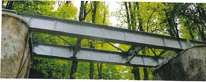
Rys. 1. Widok ogólny jednego z przęseł obiektu w km 66.501 l. 285 (fot. Maciej Kożuch)
