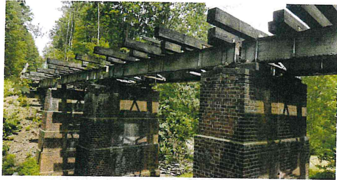
Rys. 2. Widok ogólny przęsła obiektu w km 72.378 l. 285 (fot. Maciej Kożuch)
