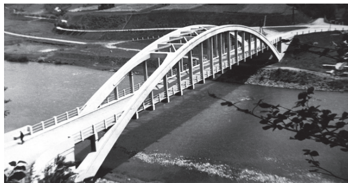
Rys. 5. Łukowy most żelbetowy w Tresnej-Czernichowie autorstwa Włodzimierza Burzyńskiego – strzałką zaznaczono lokalizację monumentu na zachodnim przyczółku (fotografia ze zbiorów Macieja Burzyńskiego )
