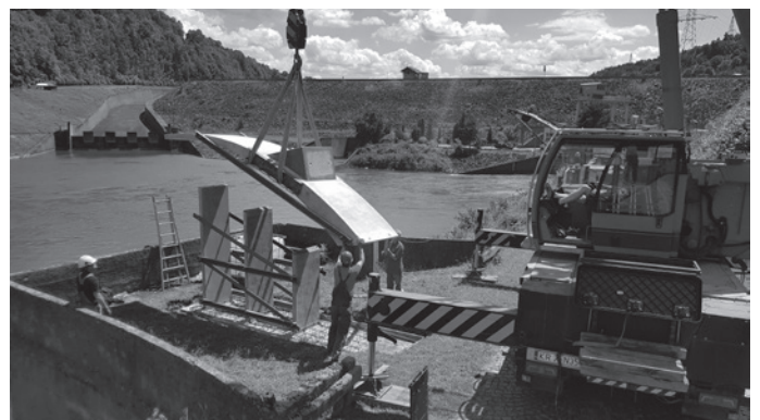
Rys. 9. Montaż monumentu (fot. W. Szczeciński)
