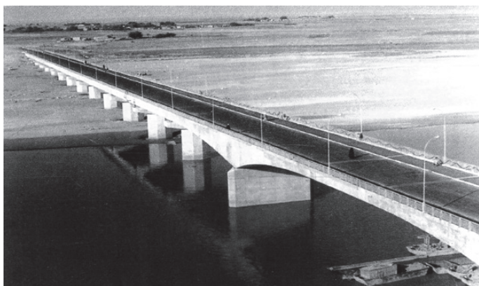
Rys. 2. Most kablobetonowy w Tikricie, w Iraku
