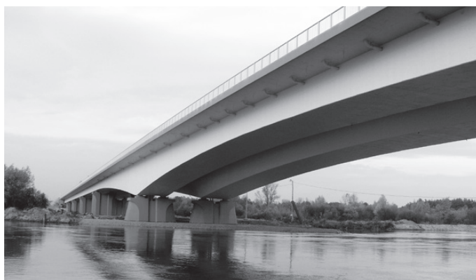
Rys. 7. Most kablobetonowy (dwie nitki) przez rzekę Bug w Wyszkowie
