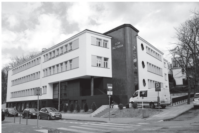
Rys. 2. Współczesny widok Domu Inżyniera w Gdyni (fot. Miron Galewski )
