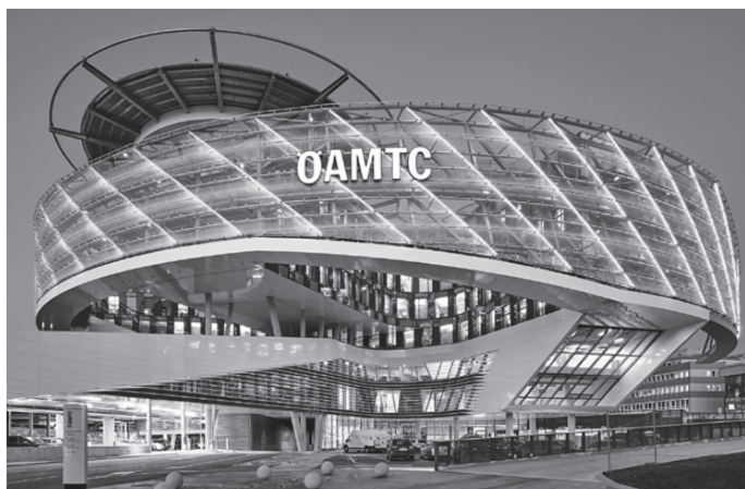
Rys. 1. Nowa siedziba firmy ÖAMTC
