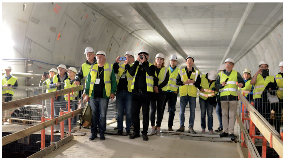
Wycieczka techniczna na budowę tunelu pod Świną
