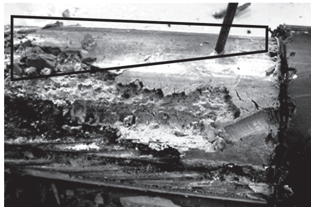
Rys. 7. Stan iniektu w zewnętrznym kablu sprężającym most Ringling-Causeway na Florydzie – w ramce obszar, w którym pH iniektu jest w zakresie 8,2 \pm 12,0 ; z prawej u góry widać szrubokręt wciśnięty w miękki iniekt (FHWA-HRT-14-039, May 2014)
