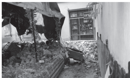
Rys. 6. Uszkodzenia restauracji znajdującej się w podwórzu P (por. rys. 1)
