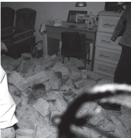
Rys. 5. Uszkodzenia poddasza kamienicy sąsiedniej C2 (por. rys. 1)
