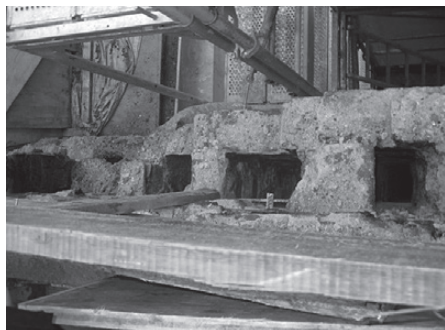
Rys. 7. Niewypełnione przewody kominowe (por. rys. 2)
