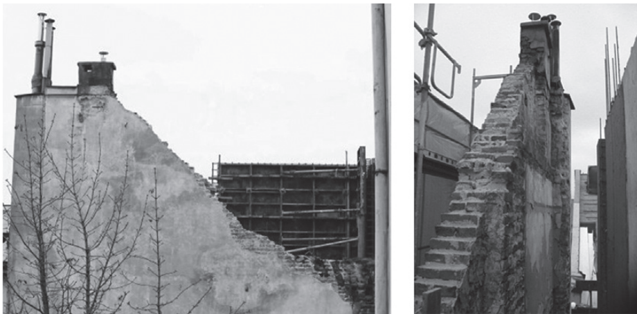
Rys. 3. Widok zniszczonej ściany granicznej pomiędzy oficynami
