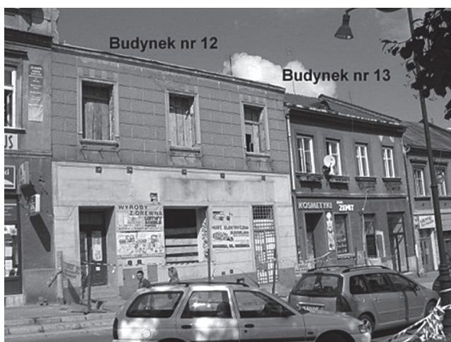
Rys. 10. Widok ogólny budynku nr 12 i nr 13 od strony frontowej
