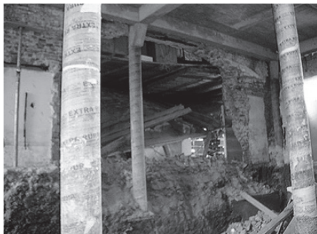
Rys. 12. I faza katastrofy budowlanej
