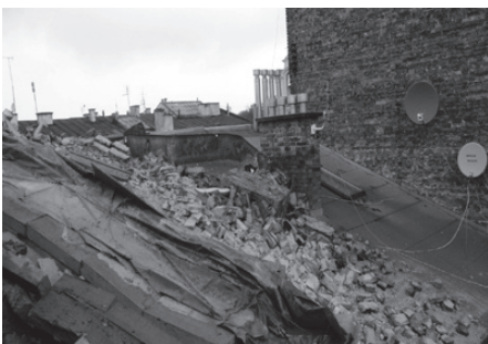
Rys. 4. Uszkodzenia dachu kamienicy sąsiedniej C2 (por. rys. 1)
