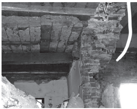
Rys. 13. Wady w strukturze muru w ścianie; ślad ścięcia ściany nad wykutą bruzdą
