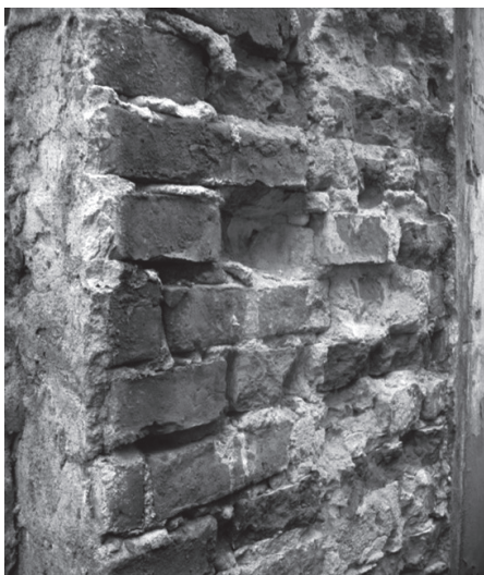
Rys. 9. Fragment pozostałej części ściany – widoczne liczne ubytki strukturalne
