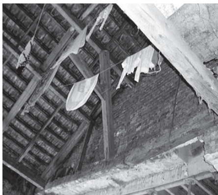
Rys. 15. Wypchnięty słupek podpierający płatew pośrednią
