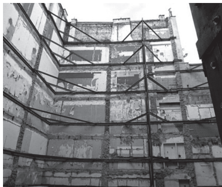
Rys. 8. Stalowa konstrukcja usztywniająca ścianę graniczną pomiędzy oficynami
