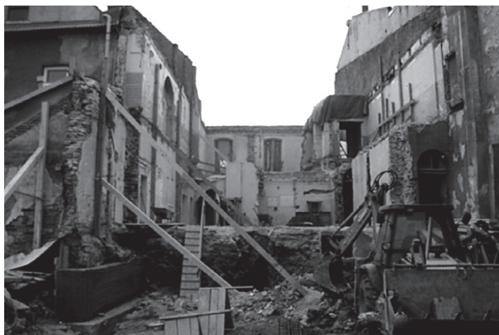
Rys. 11. Budynek nr 12 po wyburzeniu „wewnętrznej” konstrukcji
