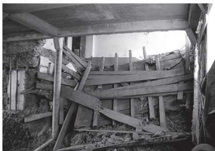
Rys. 14. II faza katastrofy budowlanej
