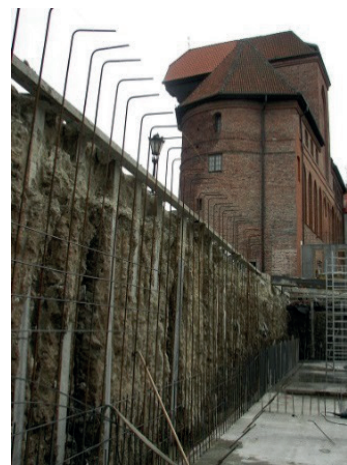
Rys. 10. Etap przygotowania do wykonania docelowej ściany konstrukcyjnej podziemia budynku po wyrównaniu powierzchni palisady DSM
