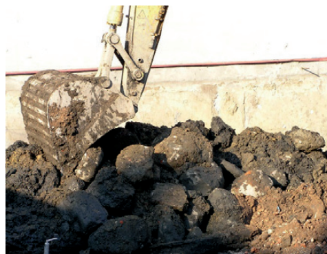
Rys. 3. Głazy narzutowe wykopane spod starych fundamentów
