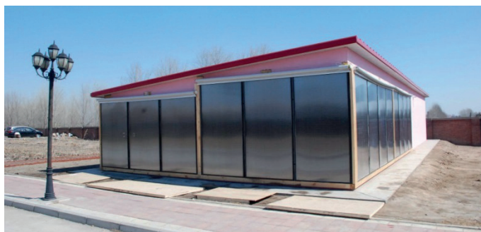
Rys. 4. Budynek z systemem słonecznym, z bezpośrednim magazynowaniem energii w ścianach, do całorocznej uprawy grzybów zbudowany w Harbinie (Chiny)
