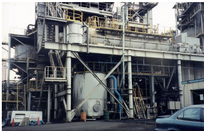
Rys. 3. Instalacja do czyszczenia i aglomeracji węgla (największa na świecie) zbudowana w Nagoi (Japonia)
