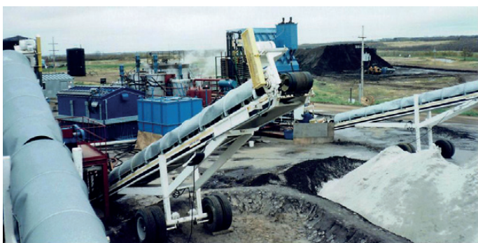
Rys. 2. Instalacja do oczyszczania osadów z osadników ropy naftowej (w tle hałda zanieczyszczona olejem ziemi i oczyszczona ziemia w postaci białego piasku) zastosowana w Albercie (Kanada)
