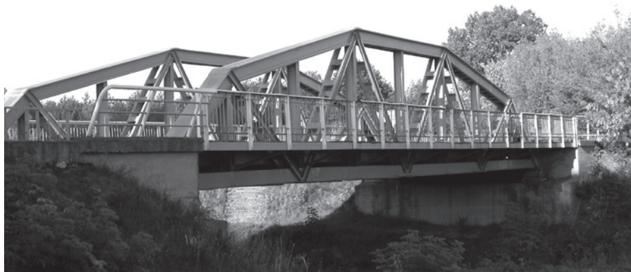
Rys. 4. Most drogowy o konstrukcji stalowej spawanej przez rzeką Słudwię. Fot. Paweł Przybysz
