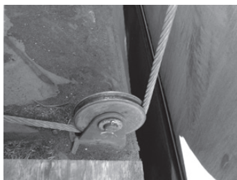
Rys. 11. Krążek zbloca linowego na obwodzie dachu zmieniający kierunek przebiegu liny z powierzchni poszycia na wspornik przyspawany na obwodzie płaszczu
