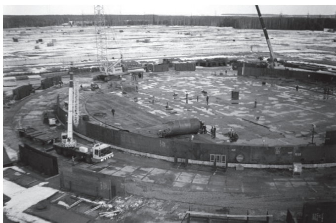
Rys. 17. Rozwijanie z rulonu pierwszej sekcji dna wewnętrznego zbiornika V = 75\,000 \text{ m}^3 z podwójnym dnem
