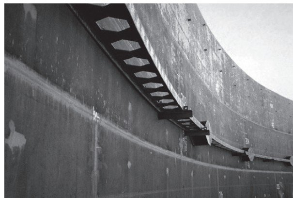
Rys. 4. Pierścień montażowy zabezpieczający płaszcz zbiornika przed deformacjami spowodowanymi parciem wiatru
