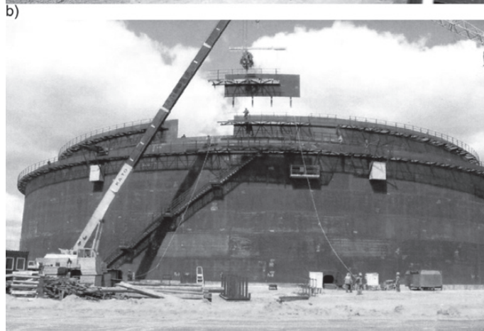
Rys. 5. Montaż najwyższego pierścienia blach płaszczu zbiornika z dachem pływającym wraz z segmentem głównego pierścienia usztywniającego: a) prefabrykacja blach na poziomie terenu, b) podnoszenie ostatniej blachy najwyższej cargi płaszczu zbiornika
