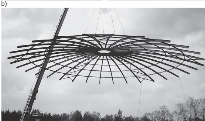
Rys. 6. Montaż dachu stałego scalonego na poziomie terenu: a) scalona konstrukcja nośna i poszycie dachu oraz najwyższa carga płaszcza, b) scalona tylko konstrukcja nośna dachu (ze względu na dużą jej masę i brak dźwigu o dostatecznej nośności)
