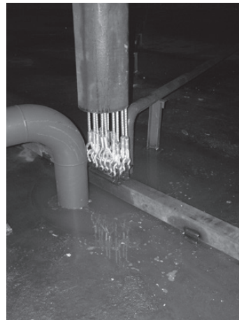
Rys. 9. Zamocowanie do dna zbiornika zespołu lin prowadzących dach podczas podnoszenia
