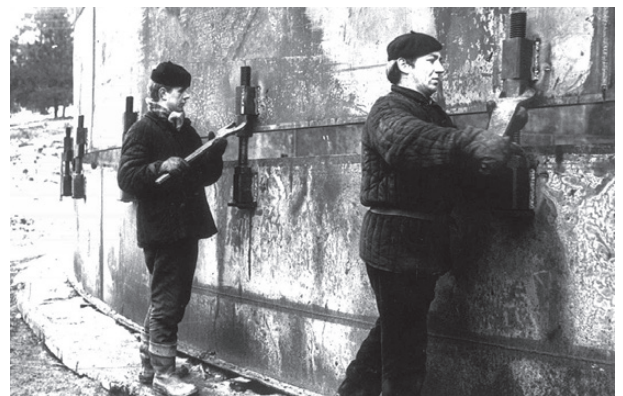
Rys. 15. Pozorowane opuszczanie górnej części zbiornika po usunięciu rolek tocznych, aby uzyskać szczelinę niezbędną do prawidłowego zespawania górnej i dolnej części płaszczu (dwóch monterów demonstruje czynność, którą w rzeczywistości musi wykonywać równocześnie kilkudziesięciu ludzi)
