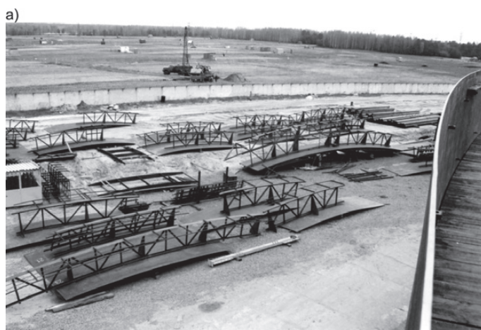
Rys. 4. Pierścień montażowy zabezpieczający płaszcz zbiornika przed deformacjami spowodowanymi parciem wiatru
