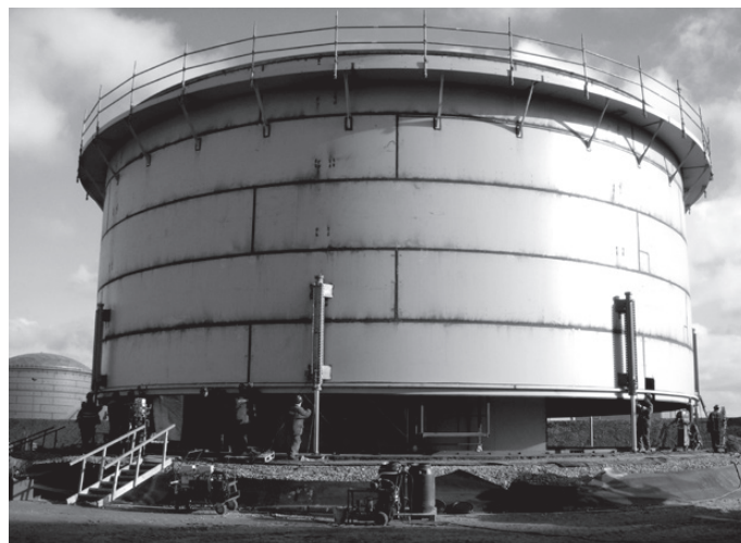
Rys. 12. Zbiornik montowany metodą podbudowy pierścieni blach płaszczu przy pionowym podnoszeniu [5]
