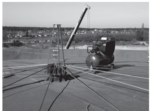
Rys. 10. Liny wyprowadzone na poszycie dachowe przez otwór w zworniku konstrukcji nośnej dachu
