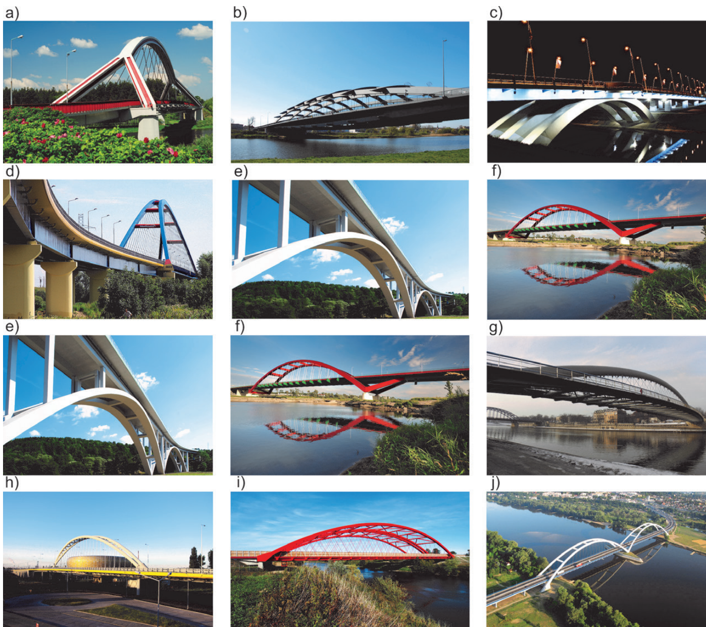
Rys. 6. Wybrane polskie mosty łukowe: a) most gen. A. Madalińskiego przez Narew w Ostrołęce (1995), b) most Kotlarski przez Wisłę w Krakowie (2001), c) most Zamkowy przez Wisłok w Rzeszowie (2002), d) most przez Dziwną koło Wolina (2003), e) most nad Doliną Kamieszniczanki koło Miłówki w ciągu drogi S69 (2003), f) most Jana Pawła II przez Wisłę w Puławach (2008), g) kładka Ojca Bernatka nad Wisłą w Krakowie (2010), h) wiadukt w ciągu Trasy Słowackiego w Gdańsku (2012), i) most przez San w ciągu autostrady A4 (2013), j) most im. gen. Elżbiety Zawackiej przez Wisłę w Toruniu (2013)
