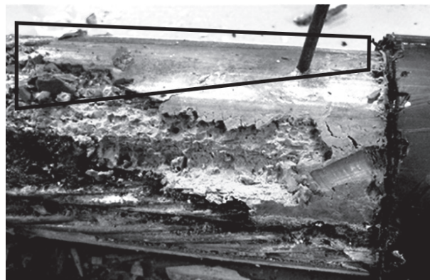
Rys. 6. Stan iniektu w zewnętrznym kablu sprężającym most Ringling Causeway na Florydzie – w ramce obszar, w którym pH iniektu jest w zakresie 8,2÷12,0; z prawej u góry widać śrubokręt wciśnięty w miękki iniekt (FHWA-HRT-14-039, May 2014)
