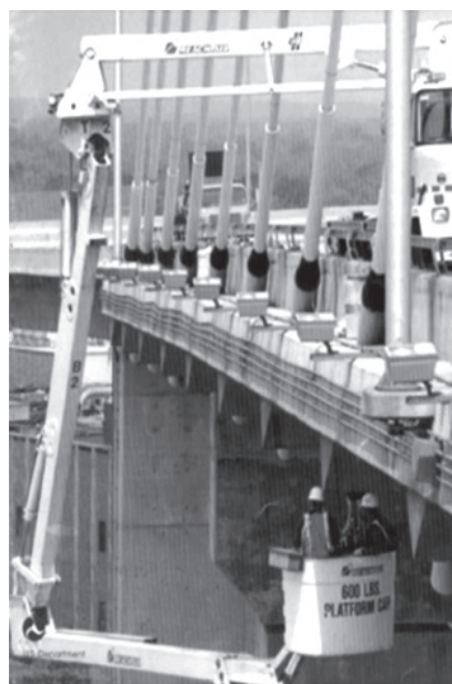
Rys. 11. Sprawdzenie dolnych zakotwień kabli podwieszających z pojazdu kontrolnego [1]
