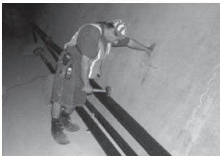
Rys. 1. Kontrola dźwiękowa młotkiem zewnętrznym kabli sprężających w skrzynkowym dzwigniku mostowym [Corven Engineering Inc.]
