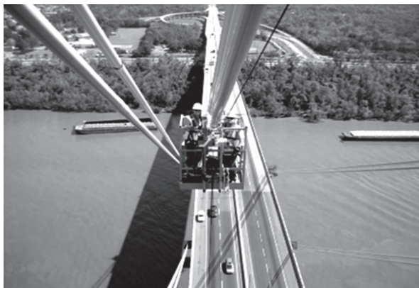
Rys. 12. Wózek stosowany do kontroli stanu kabli podwieszających mostu Luling [Mehrabi i inni, 2010, Internet]
