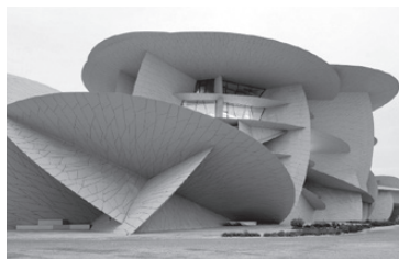
Rys. 5. Fragment obiektu – widoczne wspornikowe zadaszenia. Fot. Martin Argyroglo [1]
