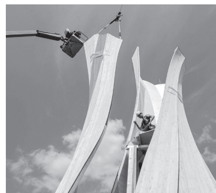
Rys. 5. Montaż konstrukcji wieży (ICD/ITKE University of Stuttgart) [1]
