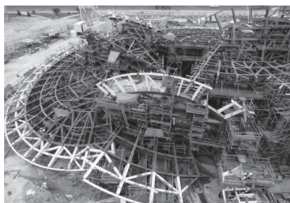
Rys. 3. Konstrukcja stalowa dysków [5]
