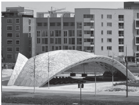
Rys. 2. Widok ogólny (fot. Roland Halbe) [2]
