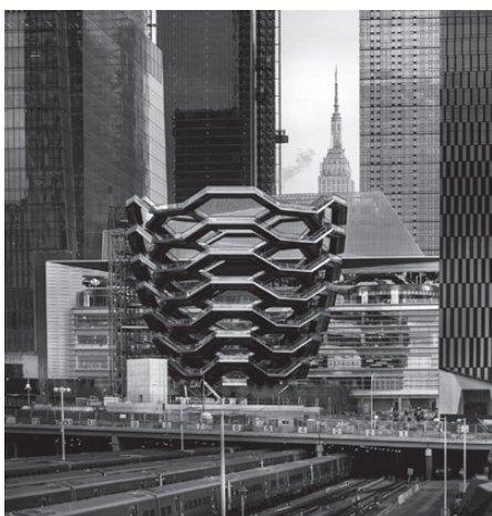
Rys. 1. Wieża Vessel – widok ogólny [4]
