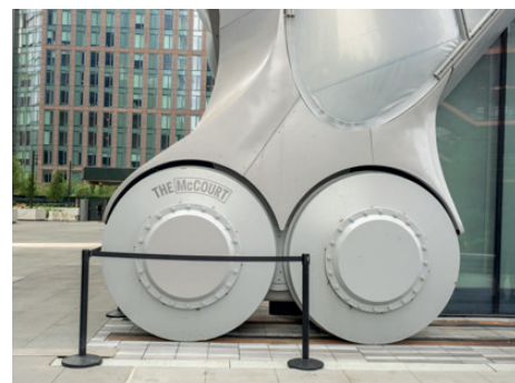
Rys. 5. Podpory ram wyposażone w koła. Fot. Ajay Suresh [1]
