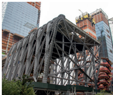
Rys. 3. Konstrukcja stalowa wiaty w trakcie realizacji. Fot. Mike Peel [1]
