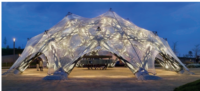
Rys. 1. Widok ogólny pawilonu (fot. Roland Halbe) [2]
