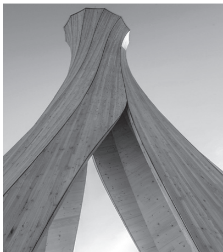
Rys. 7. Fragment konstrukcji wieży (ICD/ITKE University of Stuttgart) [1]
