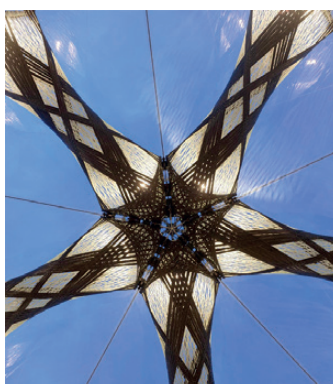
Rys. 3. Montaż konstrukcji przekrycia z elementów prefabrykowanych (ICD/ITKE University of Stuttgart) [2]
