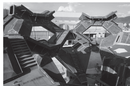
Rys. 3. Fragment konstrukcji stalowej w czasie montażu [4]
