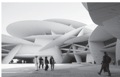
Rys. 2. Fragment konstrukcji obiektu. Fot. Ateliers Jean Nouvel; Iwan Baan [1]
