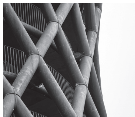
Rys. 2. Detal konstrukcji stalowej powłoki hiperboloidalnej. Fot. Rasmus Hjortshøj [2]
