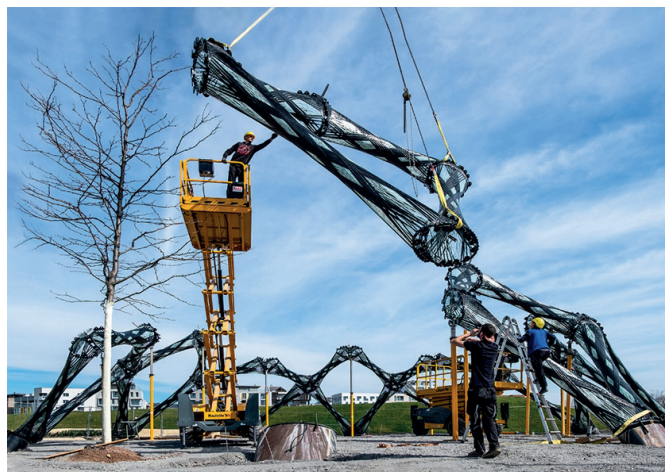
Rys. 3. Montaż konstrukcji przekrycia z elementów prefabrykowanych (ICD/ITKE University of Stuttgart) [2]
