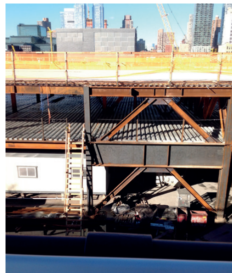
Rys. 4. Platformy o konstrukcji stalowej, na których oparto tory. Fot. Epicgenius [1]
