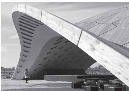
Rys. 3. Fragment styku powłok (fot. Roland Halbe) [2]
